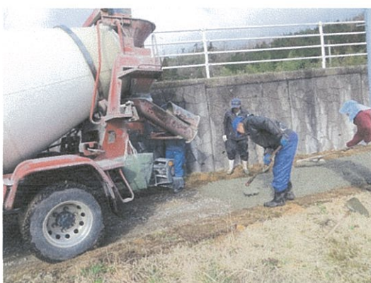
生コンの打ち込みです
