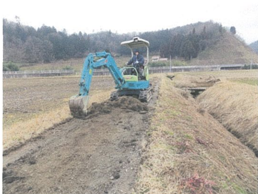
原田農道の表土剥ぎ 3月
