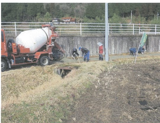
生コン車がピストン運送早く出来ました
