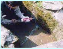
水路のひび割れ補修
