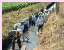
水路の泥上げ
