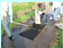
農道の部分補修
