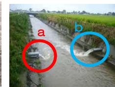
a 田んぼダム実施 b 田んぼダム未実施
