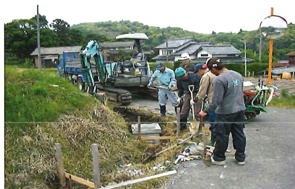
集水桝の補修
