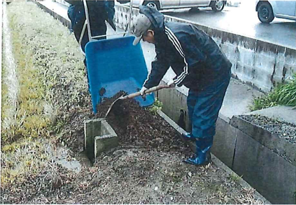
排水口の補修
