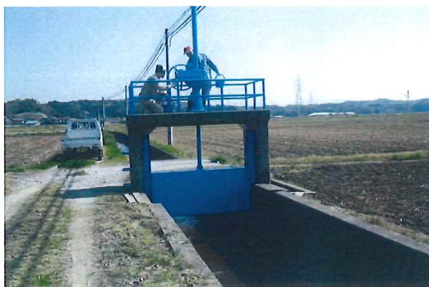
ゲートの補修
