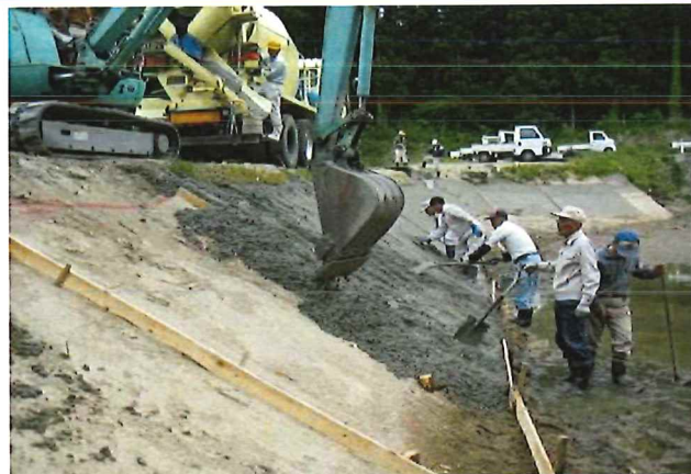
漏水箇所の補修
