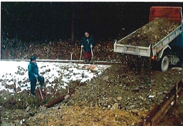
進入路の補修
