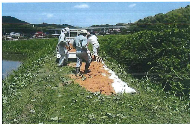
洗堀箇所の補修
