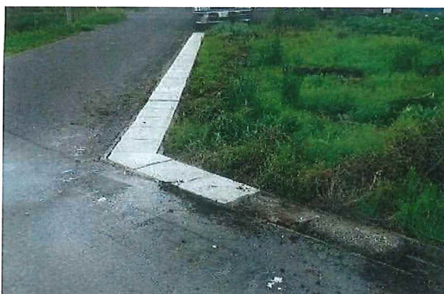
側溝蓋の設置
