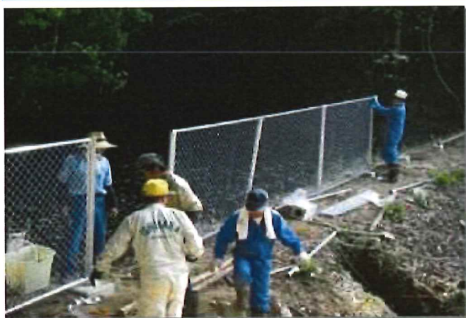
安全施設の設置
