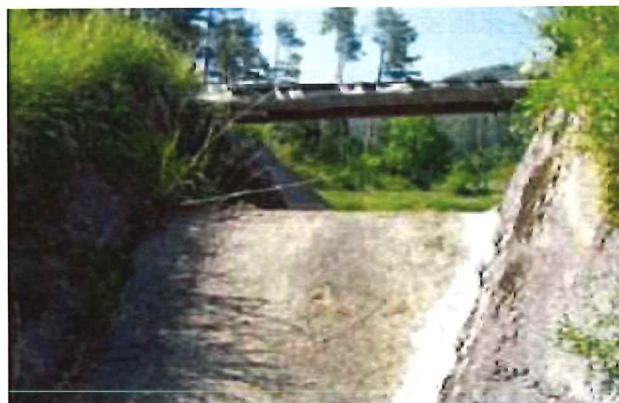
洪水吐の補修
