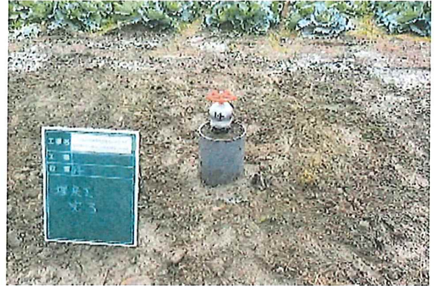
給水栓の補修
