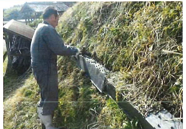
畦畔法面に小段（犬走り）の設置
