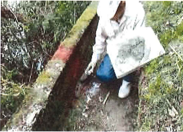
地域住民が実施する水路の軽微な補修
