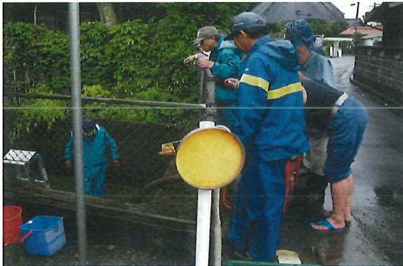
防火水槽の管理
