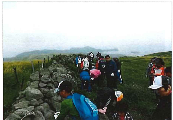
名垣の積み直し補修
