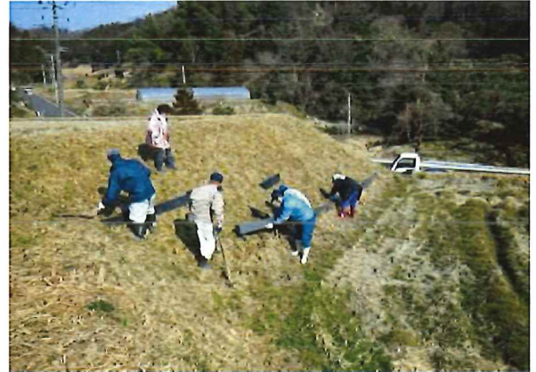
農地法面に小段を設置
