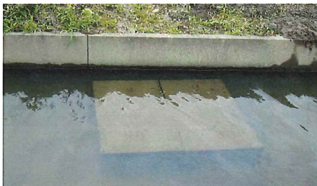
魚巢ブロックの設置
