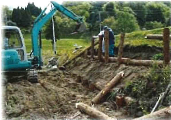
間伐材を利用し農用地法面の補修
