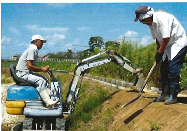
水路法面の崩壊箇所の補修
