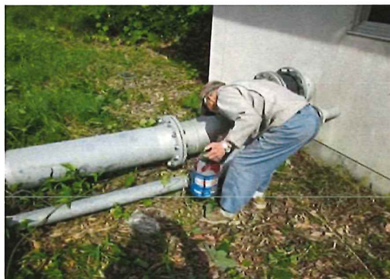
腐食防止剤の塗布
