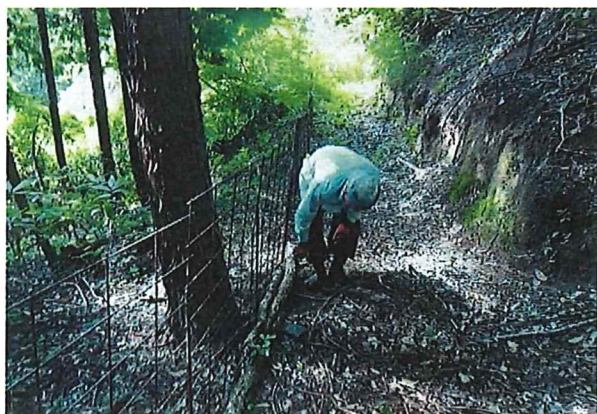
防護柵の設置
