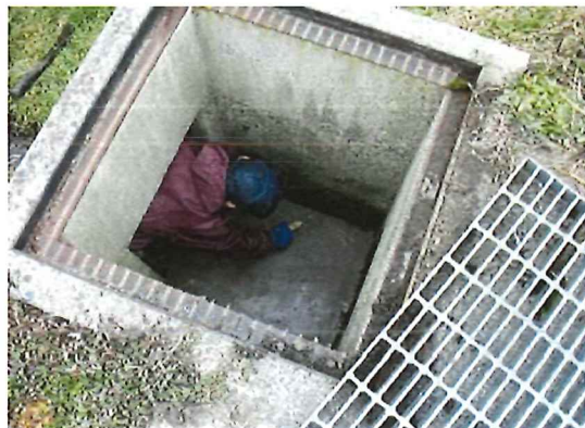
破損し漏水する水路柵の補修
