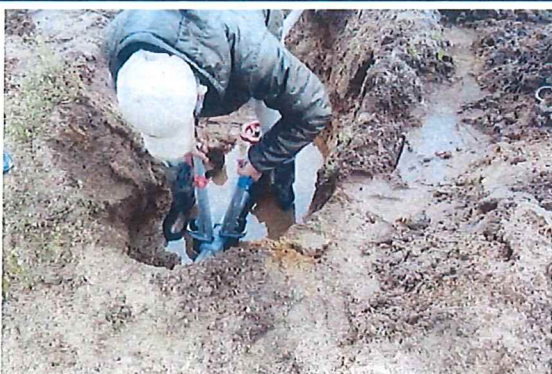
老朽化したパイプラインのバルブの改修
