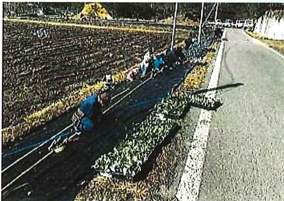
農道法面にカバープランツの植栽
