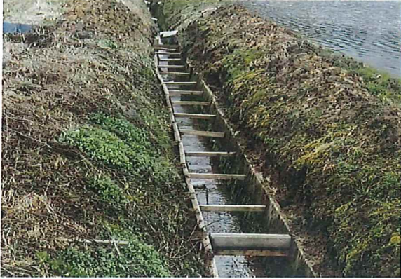
突っ張りにより補強
