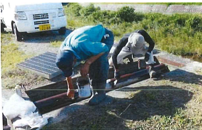
錆止め材を利用し防腐を実施
