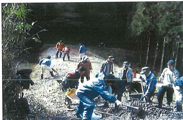
堤体の破損部分の補修
