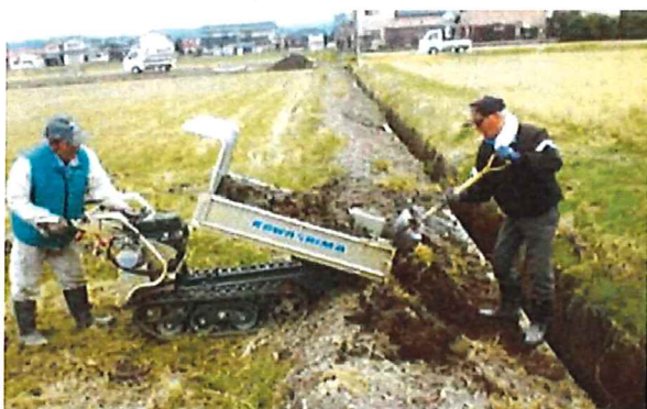
崩壊した法面の補修
