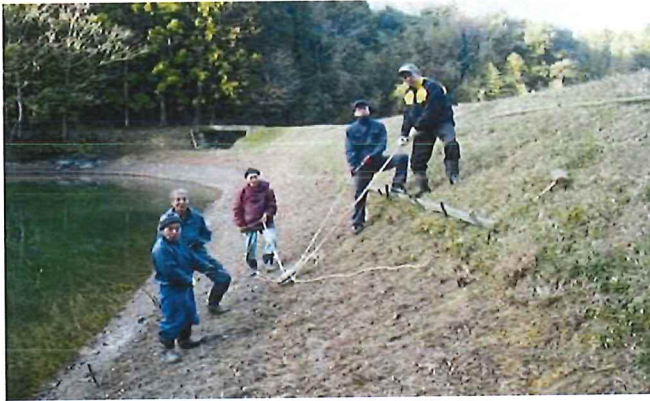
堤体の浸食箇所の補修
