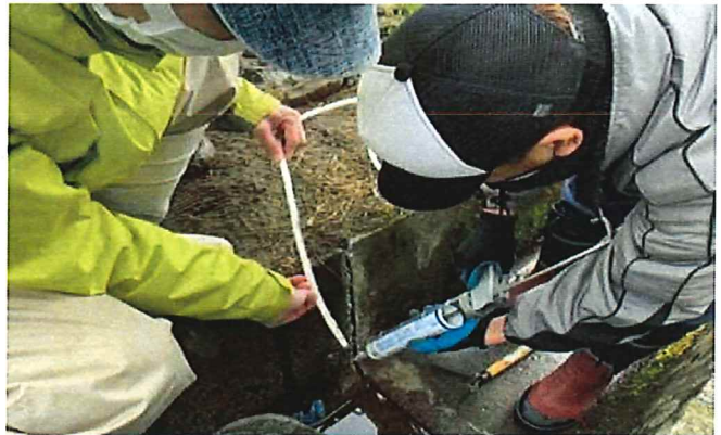
コーキング材を充填し漏水対策
