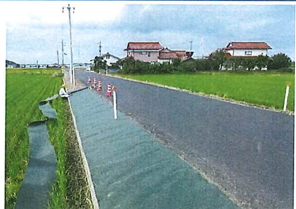
農道法面に防草シート敷設
