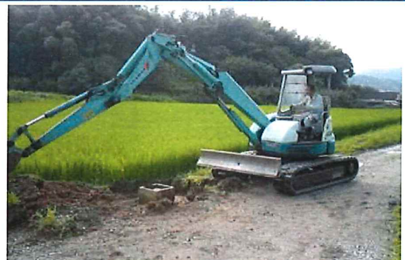
軟弱になった給水栓基礎部を重機にて締固め
