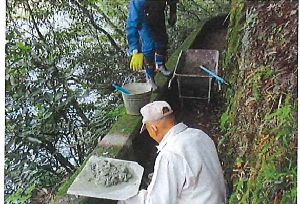
モルタルを利用した水路表面のコーティング
