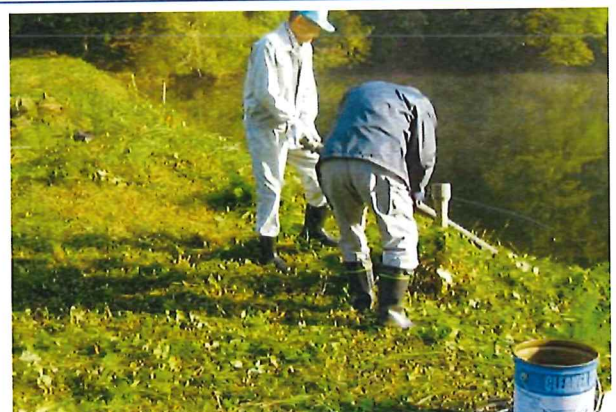
給水ホースの補修
