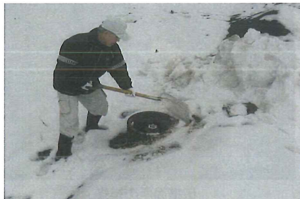
給水栓の凍結防止のため雪除けを実施
