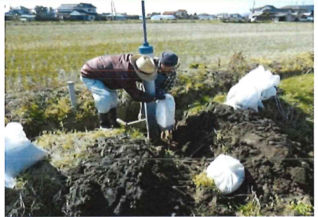
破損した水路耕畔部分に 土嚢を充填し補修
