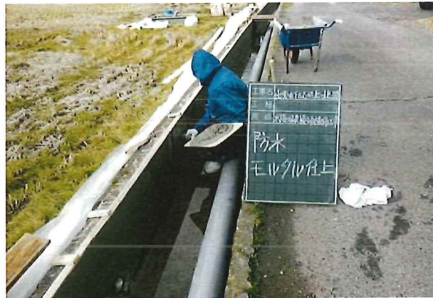
農道側溝の目地をモルタルで補修
