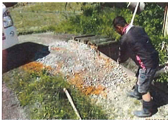
進入路の破損部分の補修
