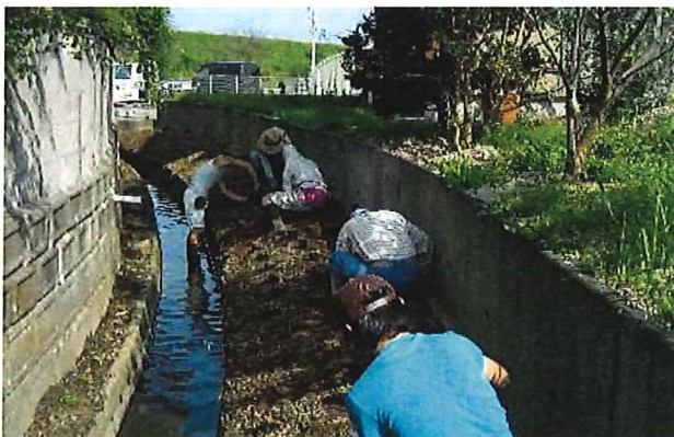
水路法面にカバープランツ（ヒメ イワダレソウ：リピア）による防草対策
