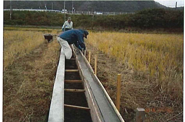
破損した水路壁の補修
