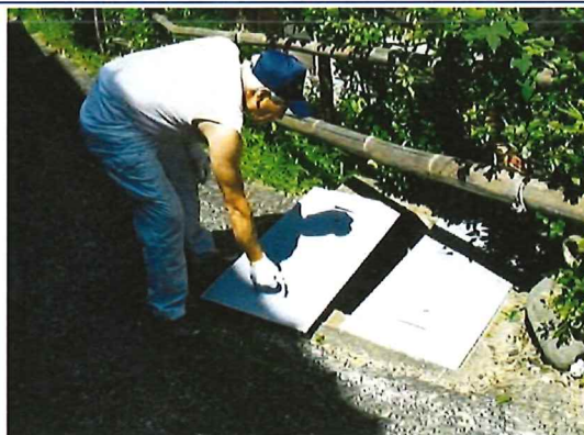
水路蓋の設置
