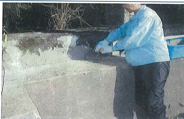
目地の開き部分にモルタルで漏水対策
