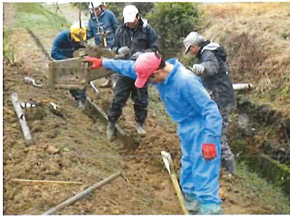
不同沈下箇所の製品を取り除き 底部基盤を整地後に再布設
