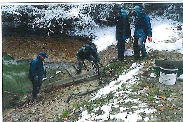
老朽化した斜樋の補修
