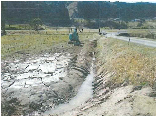
湧水进行处理するための溝切りを行い 遊休農地の発生を防止
