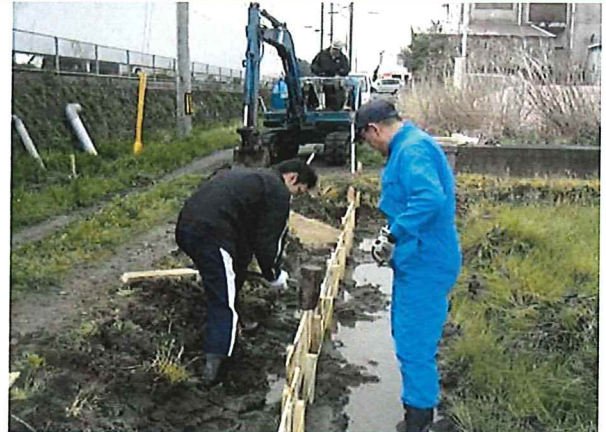
農道路肩の補修
