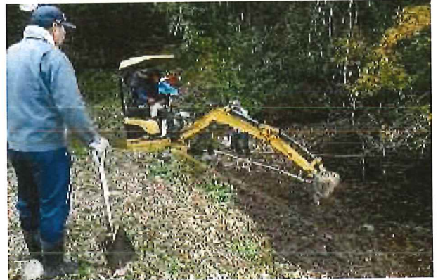
保水機能向上のため堤体の浸食箇所の補修
