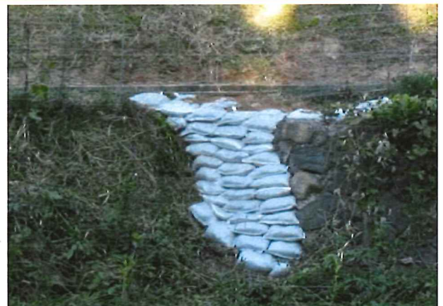
崩壊箇所に土嚢による対応
