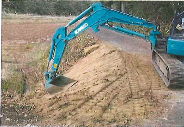
農道法面の崩壊箇所の補修
