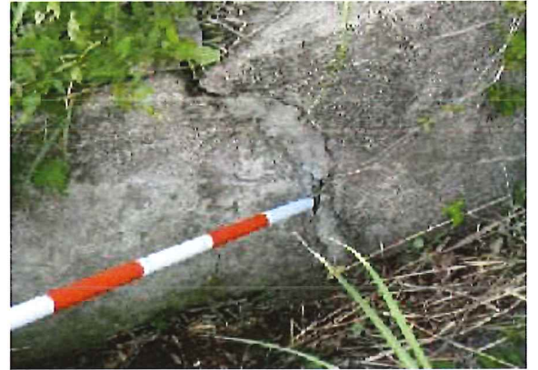
水路の機能診断
