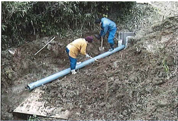
破損箇所の補修
