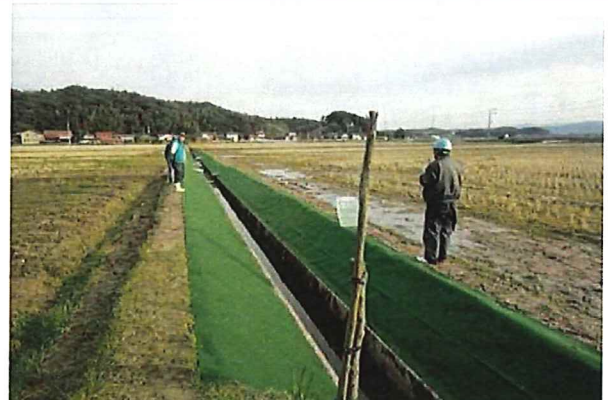
水路法面に防草シート敷設
