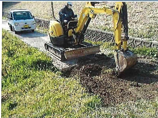
農道の破損箇所の補修
