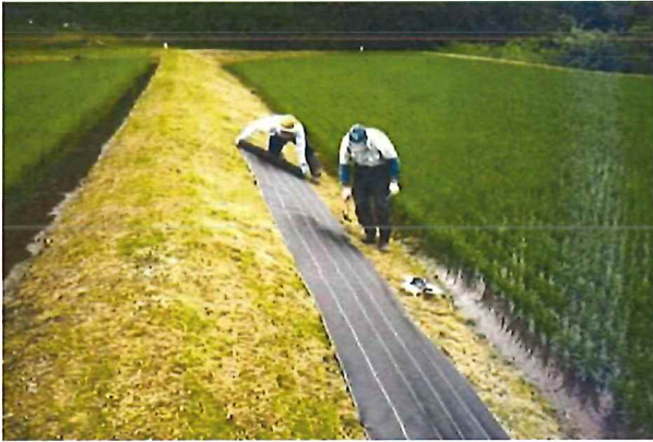
農地法面の防草シートによる雑草対策
