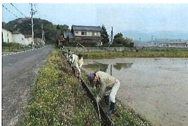
水路の泥上げ
