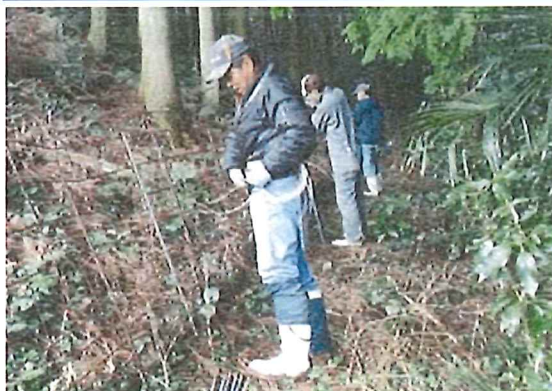
防護柵の破損箇所の補修
