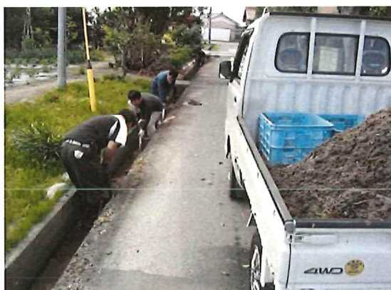
農道側溝の泥上げ
