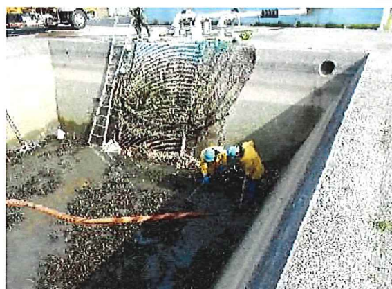
ポンプ場集水池の泥上げ
