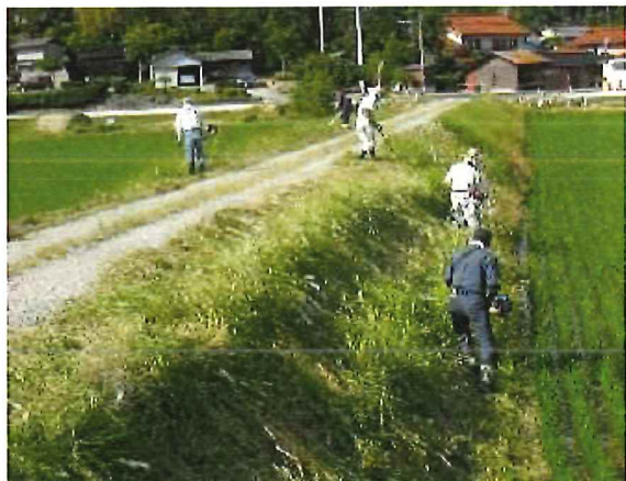
農道路肩・法面の草刈り
