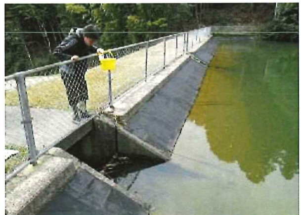
ため池の点検
