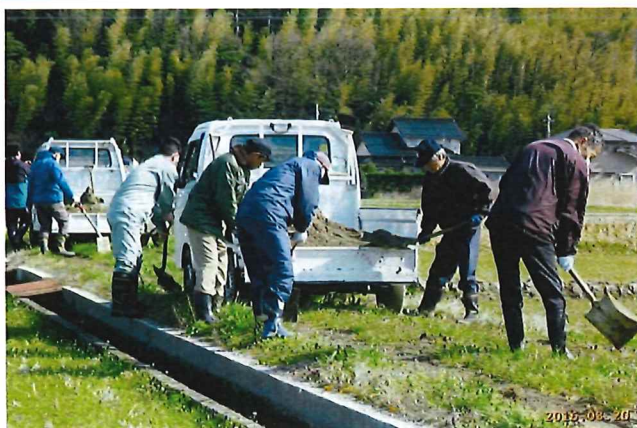
農道路面のわだち部に路盤材を補充
