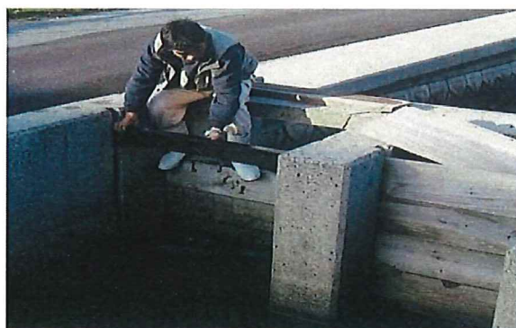
ゲート（水門板）の保守管理
