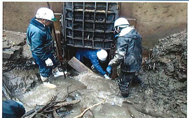
ため池底部の底樋ゲート周辺の土砂の 取り除き・保守管理
