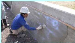
老朽化した水路壁のコーティング
