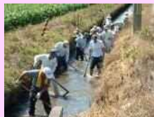
水路の泥上げ
