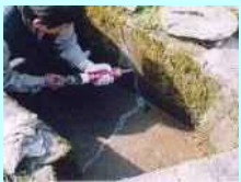
水路のひび割れ補修
