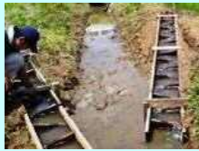
水田魚道の設置
