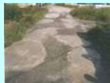
農道の窪みの補修
