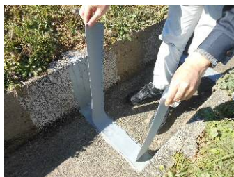
⑤アグリパッチシールを中央に合せて両側へ敷き広げる。
