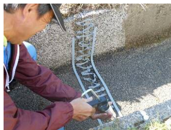
③シリコンシーリング材をコーキングガンで打設。
