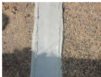
⑩-1 特に上流部に山が出来ないように滑らかにする。(砂利が溜まらないように)
