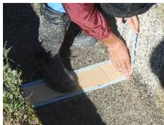
①12cm幅で養生テープを貼る。(段ボールの型紙を利用)
