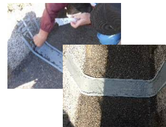
④養生テープ間を均一に塗りつけ。(15分以内に⑤へ)
