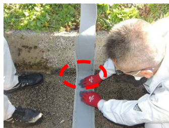
⑥空気を押し出しながらか貼る。特にコーナー部に浮きがないように注意。
