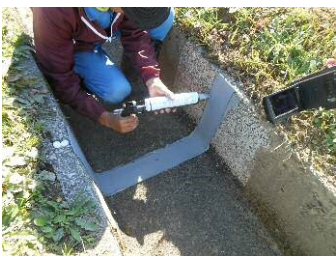
⑨シールの両側と上端部にシーリング材を補充。
