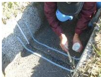
②専用のプライマーを養生テープの間に塗布。(5~10分以上おく)
