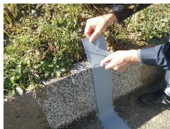
⑦シールは事前に水路製品に合った長さで準備し、最後に上端でカット。
