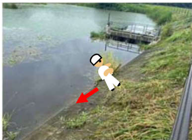
(ため池堤体の急傾斜)
