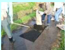
農道の部分補修
