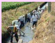
水路の泥上げ
