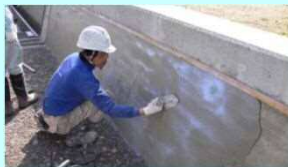
老朽化した水路壁のコーティング
