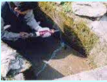
水路のひび割れ補修
