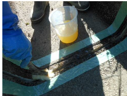
②養生テープの間に専用のプライマーを塗布。
