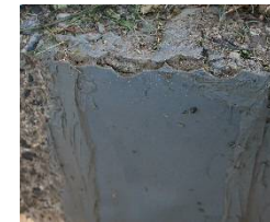
NO36施工箇所
