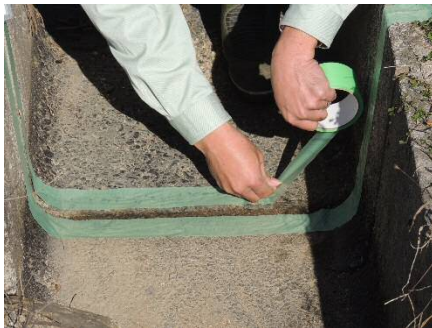
①目地から両側1cm隙間を開けて養生テープを貼る。
