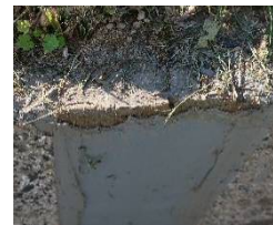
NO33施工箇所
