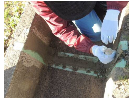
③配合したモルタルを目地部にコテで充填。
