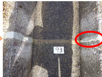
NO93施工箇所
