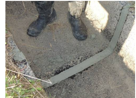
完成 養生テープを取り除いた後、コテを濡らして段差ができないようにならして仕上げる。
