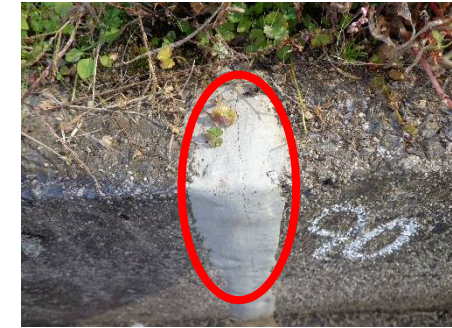
NO90施工箇所
