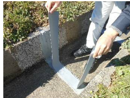
③ アグリパッチシールを中央に合わせて両側へ敷き広げ、空気を押し出しながら貼る。
