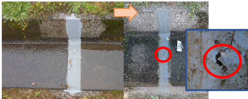
NO36施工箇所
