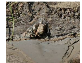
NO37施工箇所
