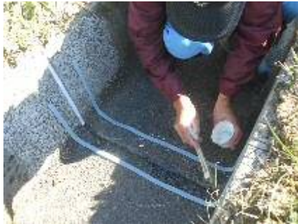
① 12cm幅の養生テープ間に専用のプライマーを塗布。
