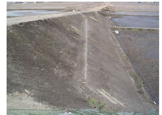
施工前の状況
