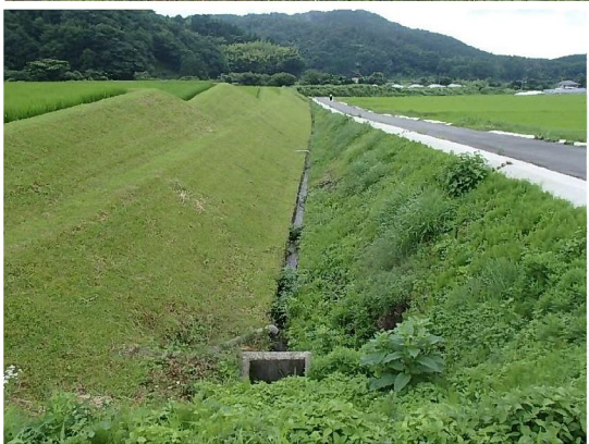
左がティフ・ブレア施工区、 右が未施工区
