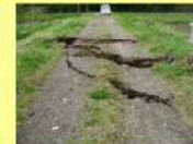
水路及び農道の破損状況
