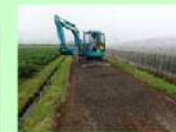
農道の復旧状況
