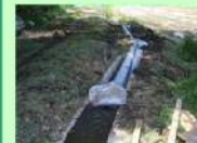
仮設配管の敷設状況
