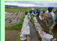
土のうの積み上げ作業
