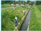
水路法面の草刈り
