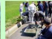
目地詰め作業
