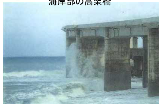
海岸部の高架橋
