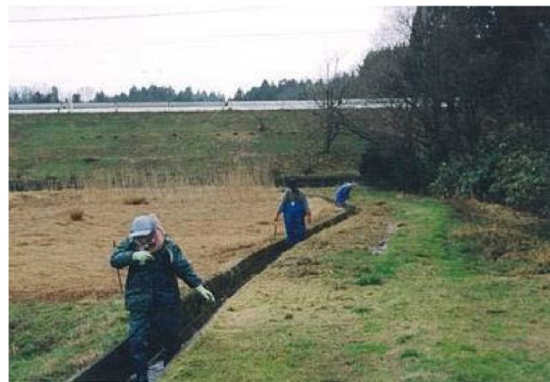
開水路における機能診断の実施状況
