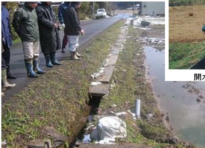
開水路の点検状況
