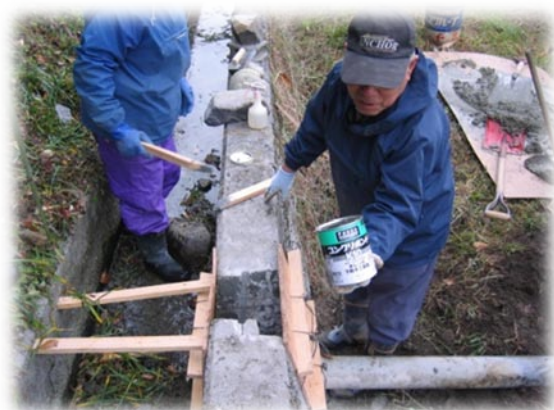
開水路の補修
