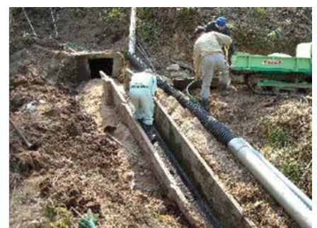
どーべだ水路補修
