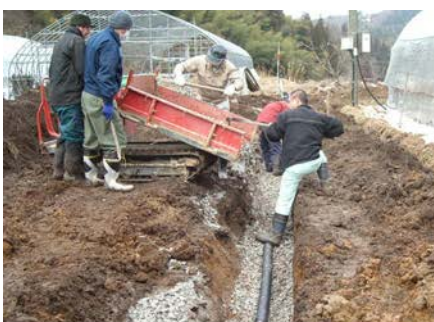
原田前暗渠排水補修
