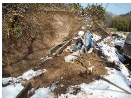
空小屋水路補修
