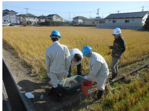
補修材の作成
