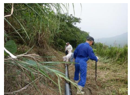
水路の泥上げ
