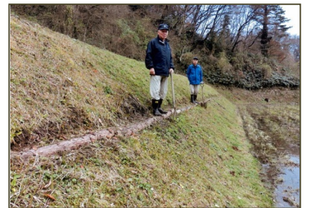
図1) 間伐材による小段設置
