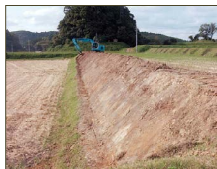
図3) 畦畔削り取りによる小段工事事例
