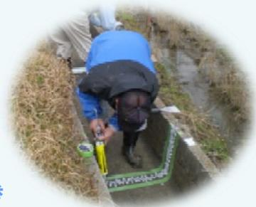
高耐久性テープは、超耐候性のフッ素フィルムで構成され、水路清掃後、良く乾かし、目地部分に市販のポリウレタン樹脂系シーリング材で貼っていく簡易補修用のテープです。
