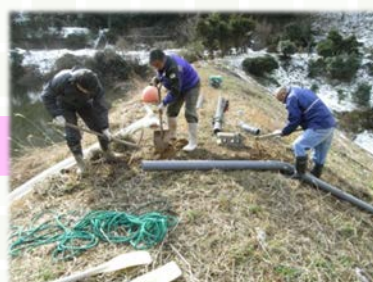
堤体への埋設
